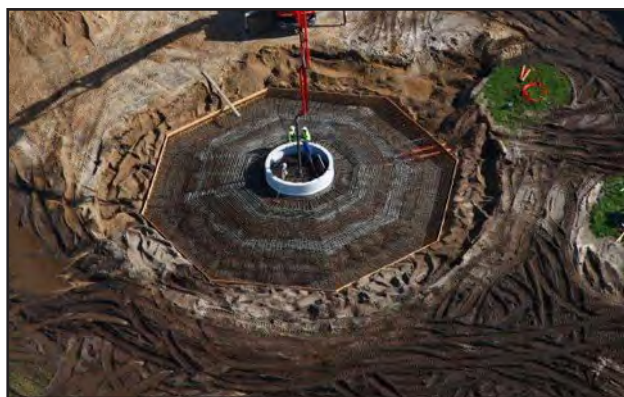
Støbning af fundament. Kilde: Hansen & Larsen, Skjern
