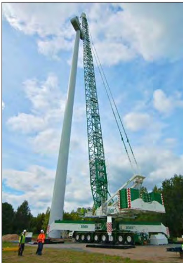
Montering af Vindmøletårn. Kilde: BMS
