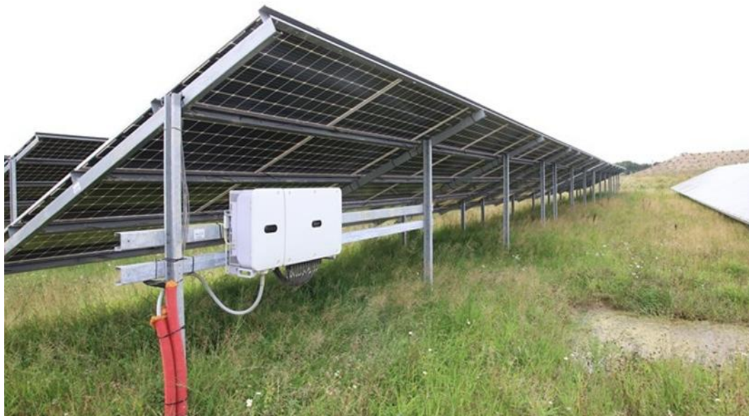
Figur 3-5. Eksempel på inverter, som placeres under solcellerne. Invertere omdanner jævnstrøm til vekselstrøm.
