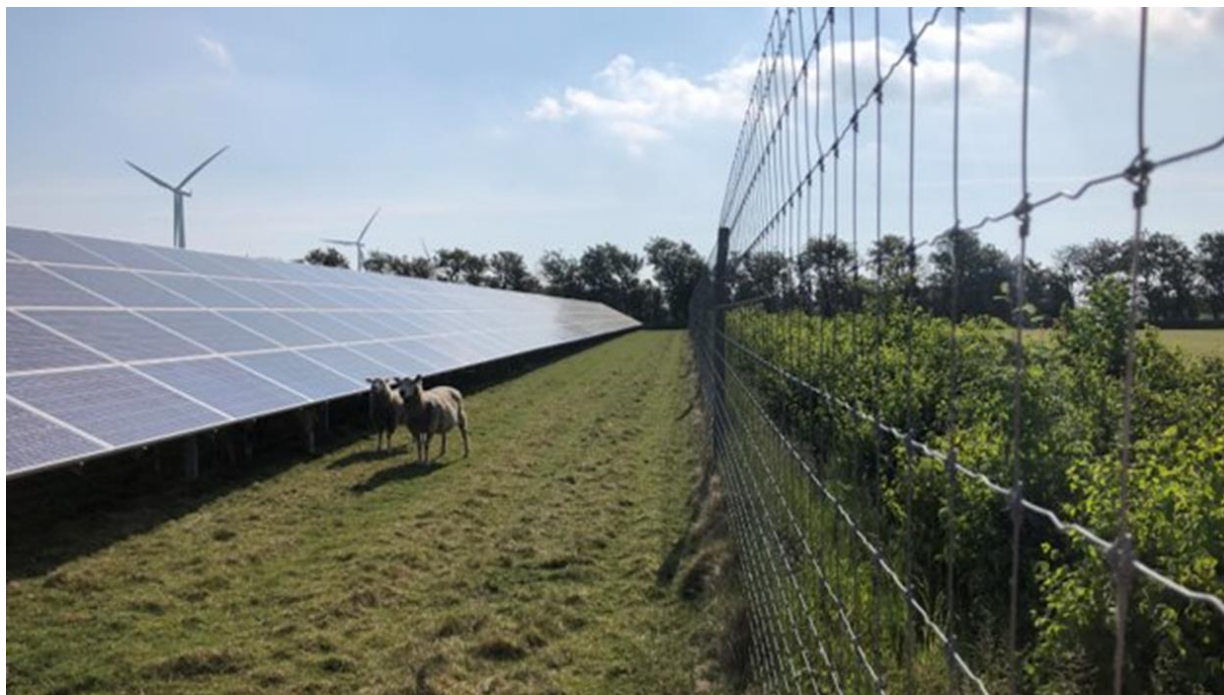
Figur 3-3 Eksempel på solcellepaneler på faste stativer, vildthejn og beplantningsbælter (ikke fuldt udvokset).
