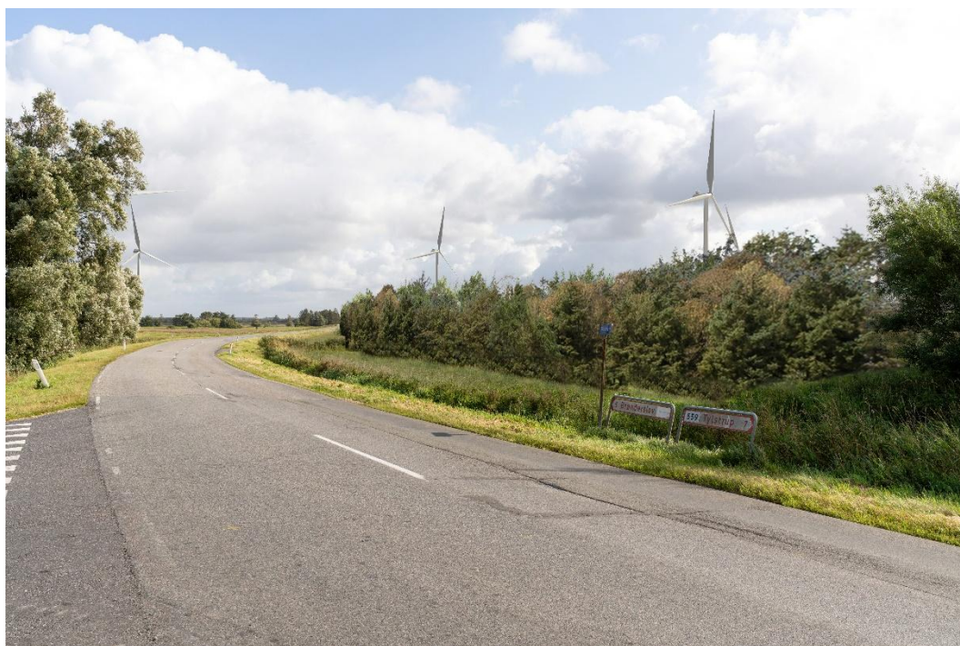
Figur 14-53. Visualisering 31 beplantning - Projektet set fra Grishøjgårdsvej/ Vildmosevej.
