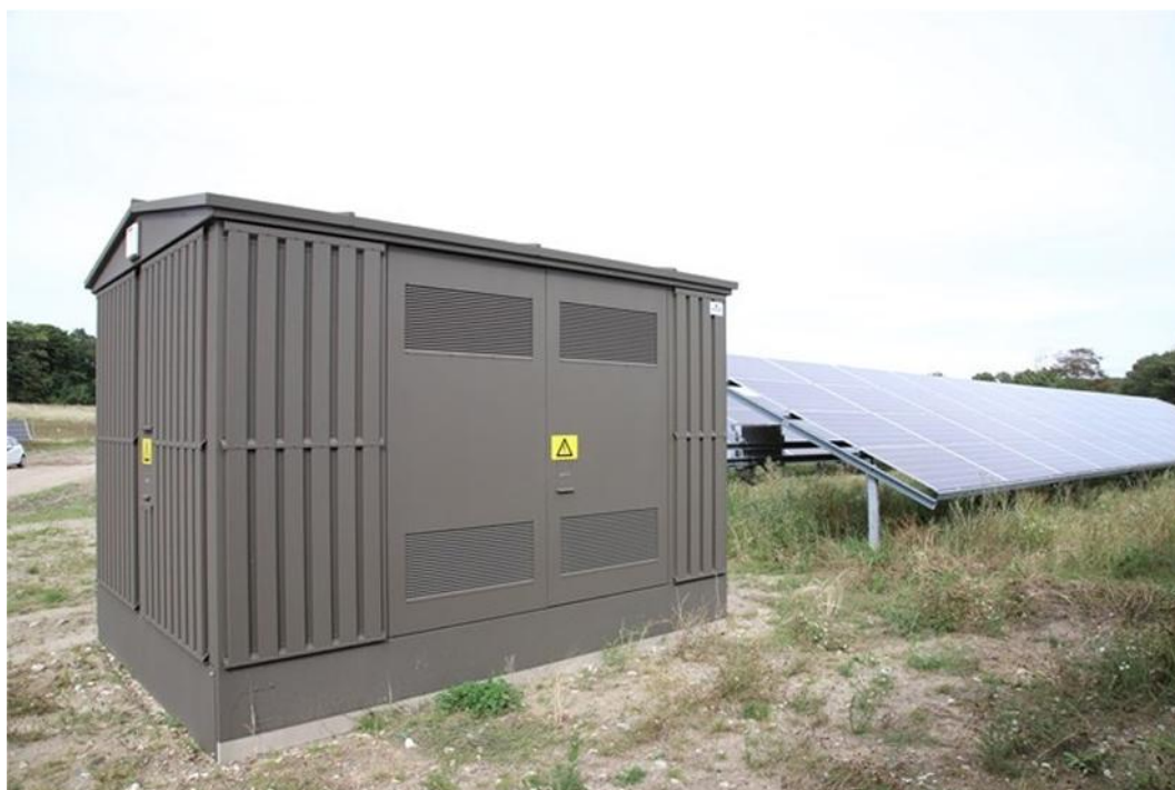
Figur 3-6. Eksempel på teknikbygning.
