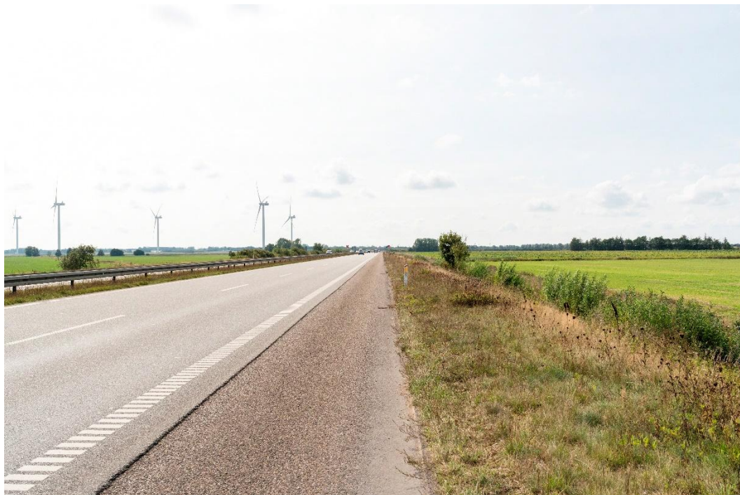
Figur 14-40. Standpunkt 30 - Projektområdet set fra Hirtshalsmotorvejen i en nord til sydgående retning.
